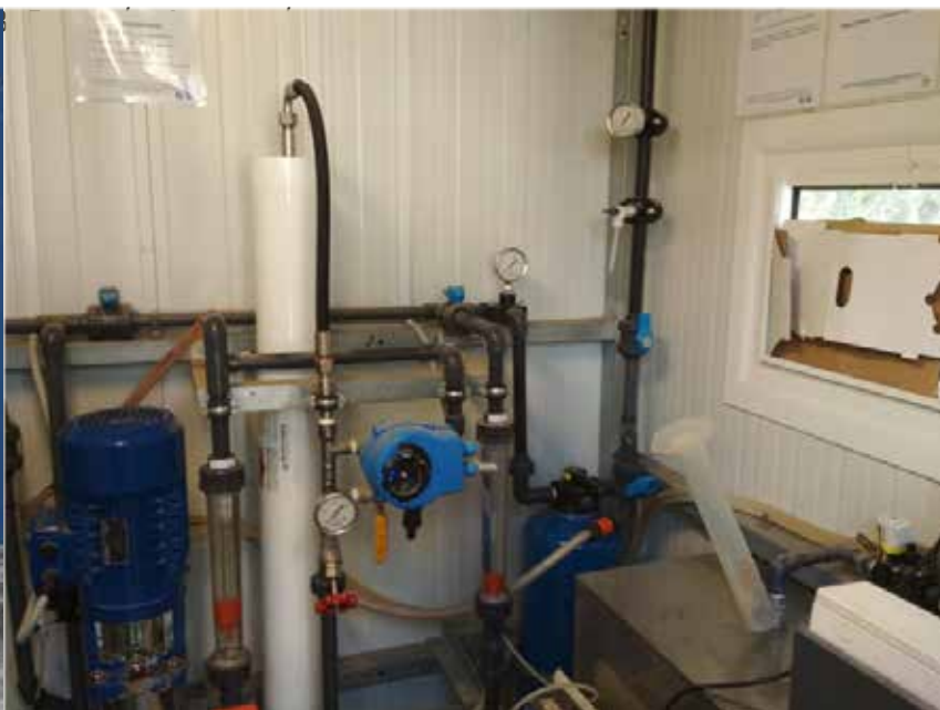
Εικόνα-4: Μηχάνημα αφαλάτωσης ΤΕΜΑΚ (ΔΕΥΑΚ Καλύμνου)
